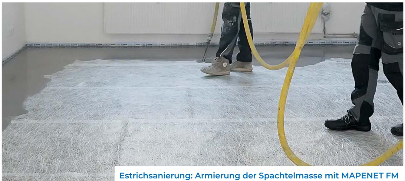
Estrichsanierung: Armierung der Spachtelmasse mit MAPENET FM
