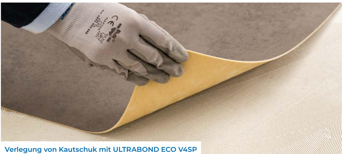
Verlegung von Kautschuk mit ULTRABOND ECO V4SP
