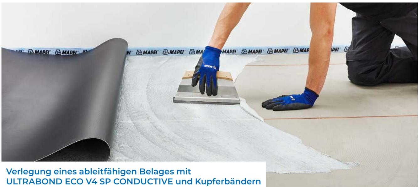
Verlegung eines ableitfähigen Belages mit ULTRABOND ECO V4 SP CONDUCTIVE und Kupferbändern
